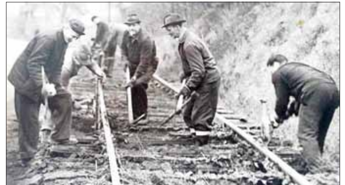
Bild 5: Gleisrückbau am Farnrodaer Feldschlösschen im November 1967
